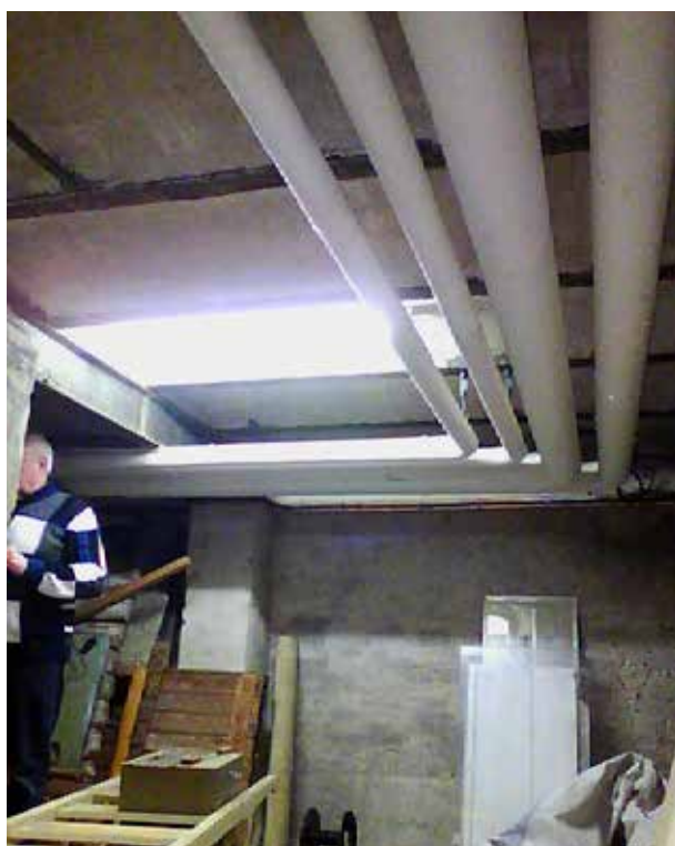
Ongeïsoleerde leidingen in de kruipruimte van de Canisiuskerk in Nijmegen; ze geven veel energieverlies.
