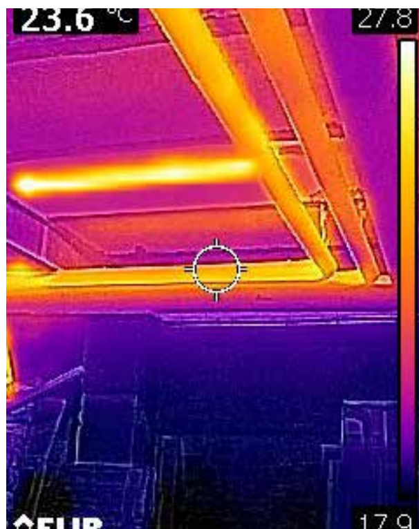
Ongeïsoleerde leidingen in de kruipruimte van de Canisiuskerk in Nijmegen; ze geven veel energieverlies.
